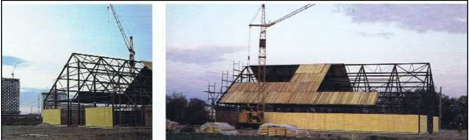
Bau der Notkirche St. Rita 1968
