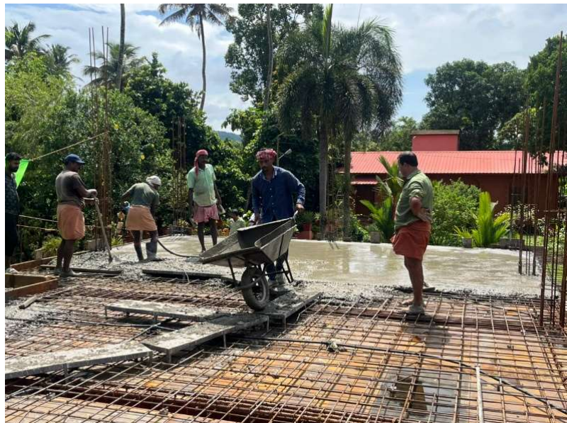
Baustelle des Administrationsgebäudes
