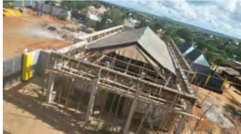
Der Neubau der Kirche nimmt Formen an
