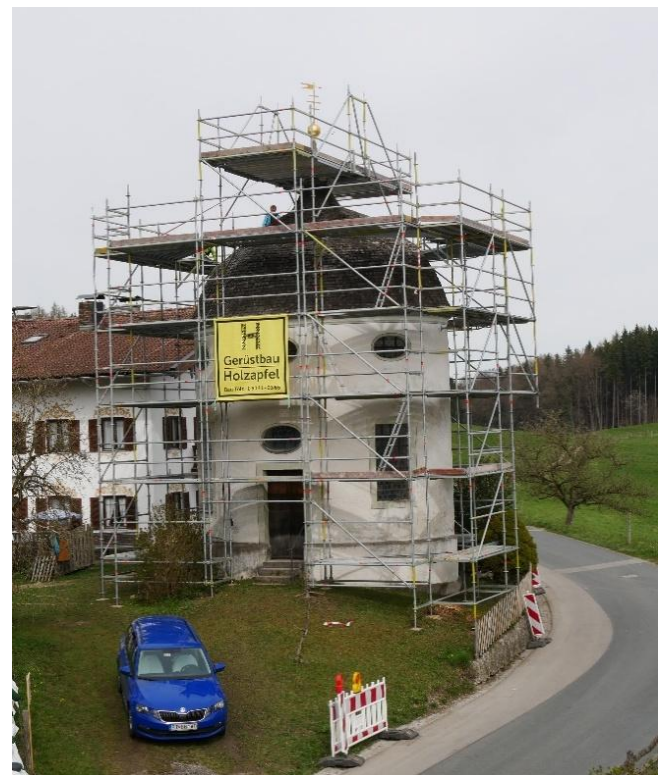
Die Bauarbeiten können beginnen: die Allerheiligenkapelle in Reichersdorf ist nun eingerüstet
