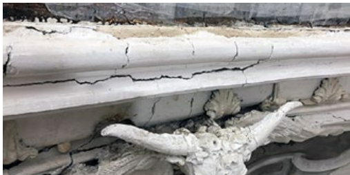
Foto links: Schadhafte Stuck an der Kirchenkuppel, Foto rechts: Beispiel für den Grad der Verschmutzung
